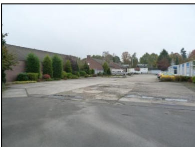
Figuur 17. Terrein Businesscenter Rosmalen geïen in zuidelijke richting.
