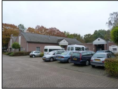
Figuur 10. Te slopen bedrijfspanden op oostelijk deel van de projectlocatie, gezien in zuidoostelijke richting.
