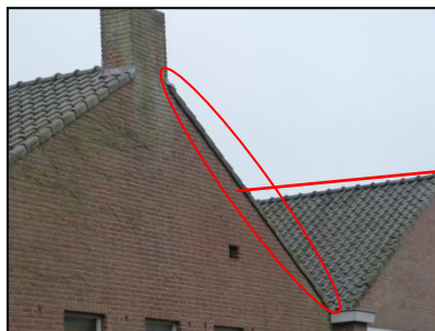
Figuur 21. Overhangende dakpannen op te slopen panden.
