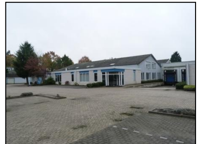
Figuur 14. Te slopen kantoorpand Businesscenter Rosmalen.
