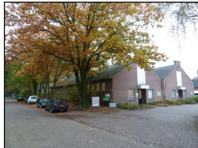
Figuur 4. Te slopen bebouwing langs oostgrens, gezien in zuidelijke richting.
