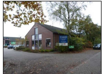
Figuur 5. Te slopen bebouwing langs oostgrens, gezien in noordelijke richting.
