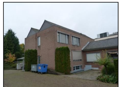
Figuur 19. Te slopen kantoorpand in de noordoost hoek van de projectlocatie.
