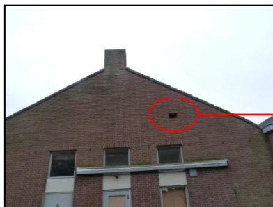
Figuur 24. Gat in muur te slopen pand.
