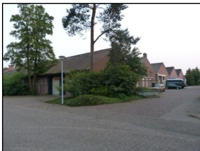
Figuur 6. Te slopen bebouwing op noordoostelijk deel van de projectlocatie.
