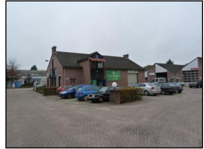
Figuur 11. Te slopen bedrijfspanden op oostelijk deel van de projectlocatie, gezien in noordwestelijke richting.
