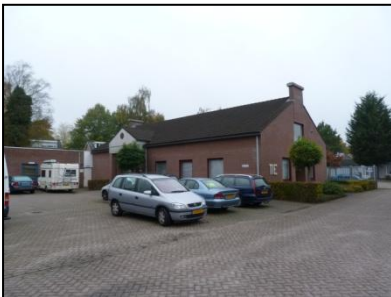
Figuur 12. Te slopen bedrijfspanden op oostelijk deel van de projectlocatie, gezien in zuidwestelijke richting.
