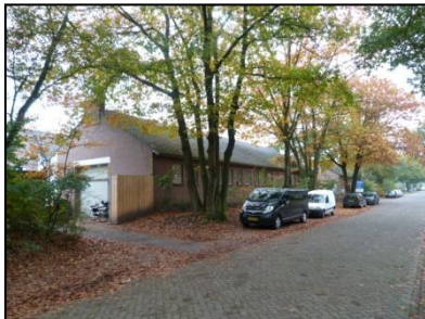
Figuur 3. Te slopen bebouwing in de zuidoosthoek van de projectlocatie.
