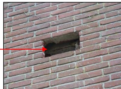
Figuur 25. Toegankelijk spouwmuur.
