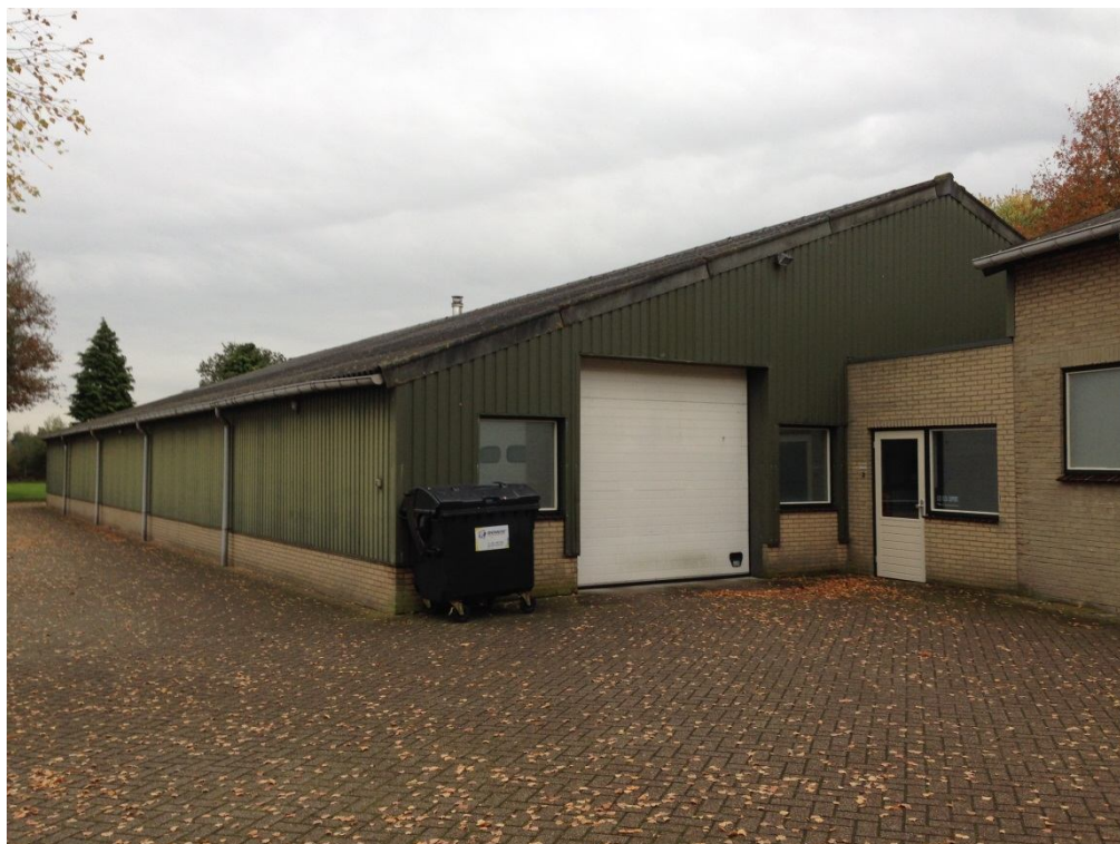
Figuur 4 Bedrijfsloods (met rechts de tussenbouw)
