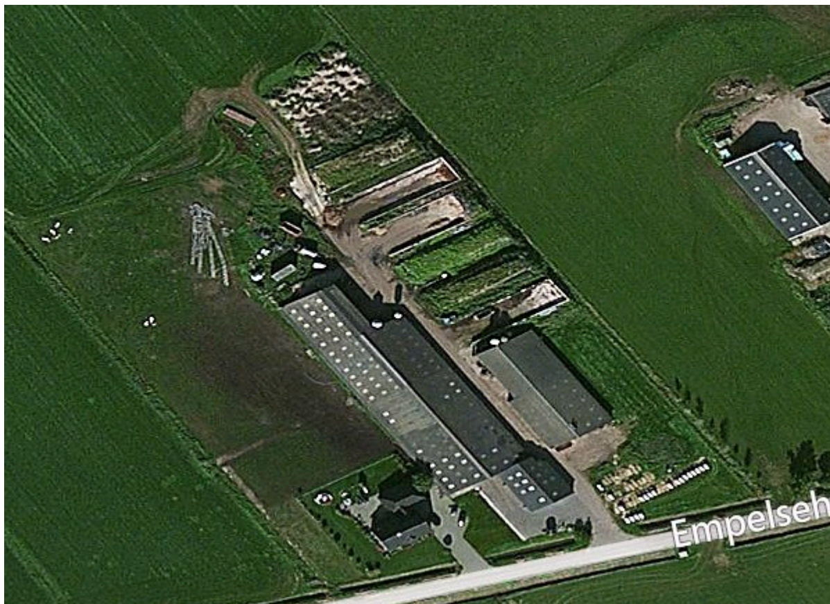
Luchtfoto huidige situatie.
