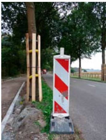
boombescherming bij uitvoering van werkzaamheden
