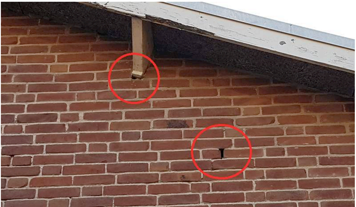
Afbeelding 3: Rood omlijnd enkele voorbeelden van openingen welke toegang bieden tot de luchtpouw in de grote zuidwestelijke loods. Foto: B. Verhoeven Ecoresult B.V.
