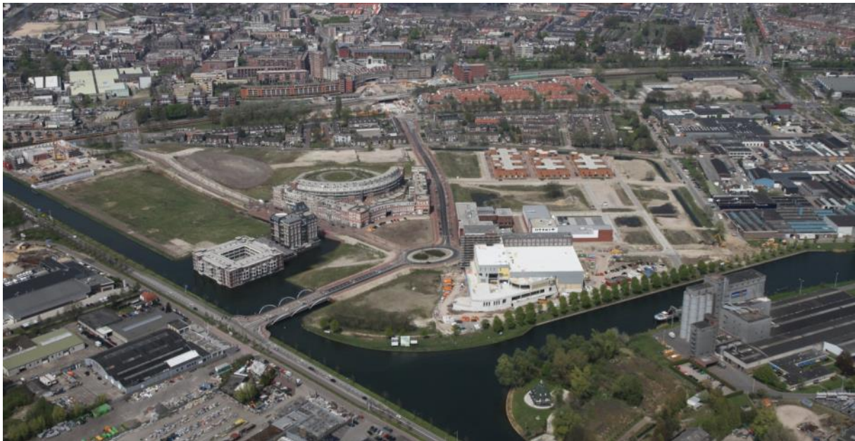
Suytkade anno 2014, gezien vanuit het zuiden
