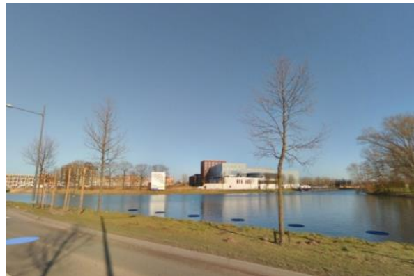
Markante zichtlocatie vanuit het zuiden
