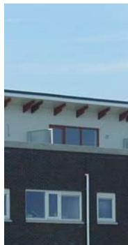
Terugliggende bovenste laag, aandacht dakranden.
