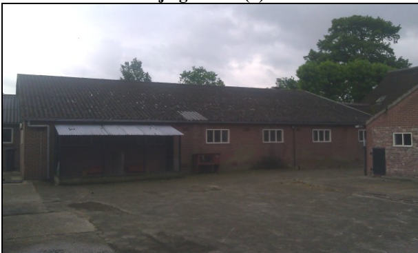
Te slopen bedrijfsgebouw (4)
