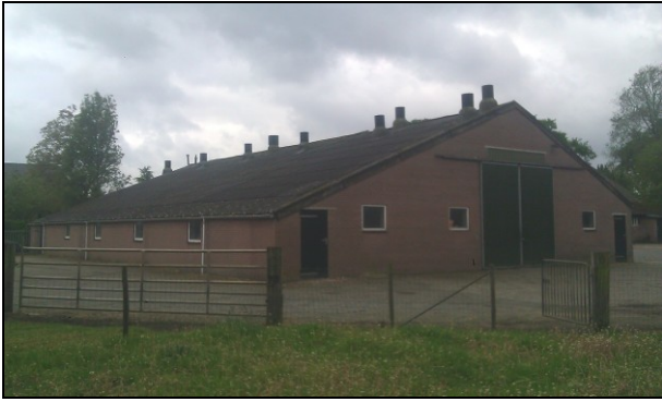
Te handhaven bedrijfsgebouw (2)
