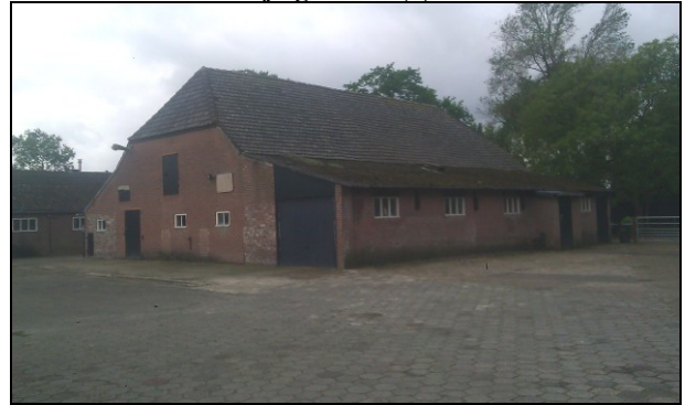
Te slopen bedrijfsgebouw (1)
