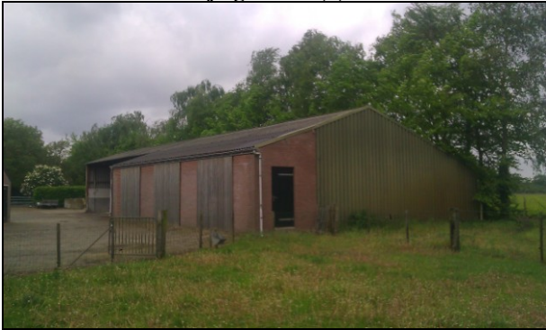
Te handhaven bedrijfsgebouw (7)
