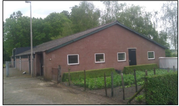
Te handhaven bedrijfsgebouw (6)
