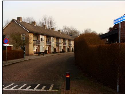
Foto 1 links voor het gebouw langs begint fase 2.
