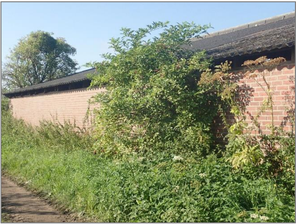
Afbeelding 2.3 | Te slopen stal
