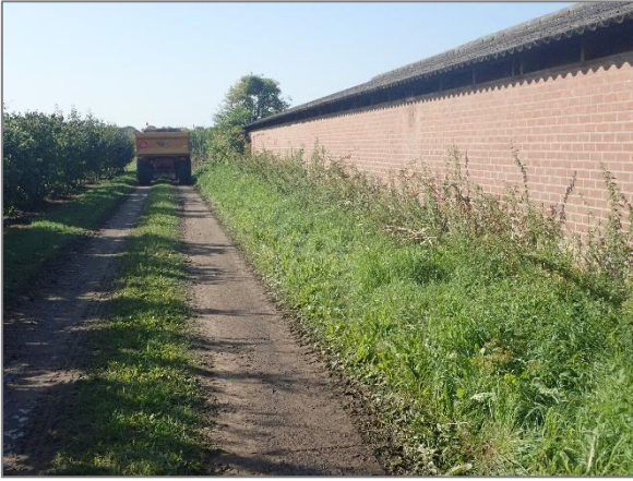
Afbeelding 2.1 | Te slopen stal
