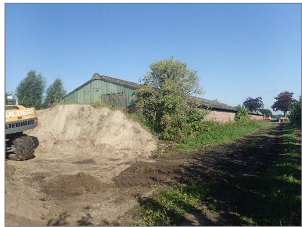
Afbeelding 2.6 | Achterzijde te slopen stal
