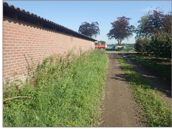
Afbeelding 2.2 | Te slopen stal
