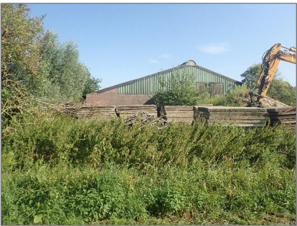
Afbeelding 2.5 | Achterzijde te slopen stal
