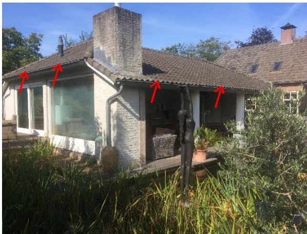
Fig.8 Verblijfplekken aan de oost en zuidkant van het zwembadgebouw.
