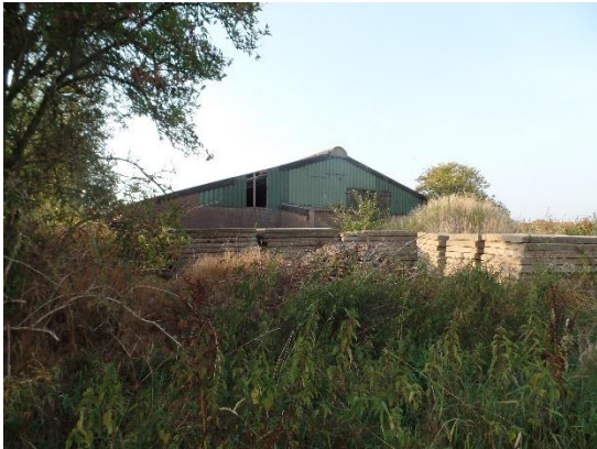
Fig.11. Opslag materialen aan achtergevel
