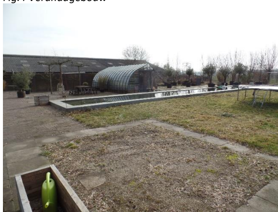
Fig.6 Zicht op tuin en veestal die afgebroken wordt
