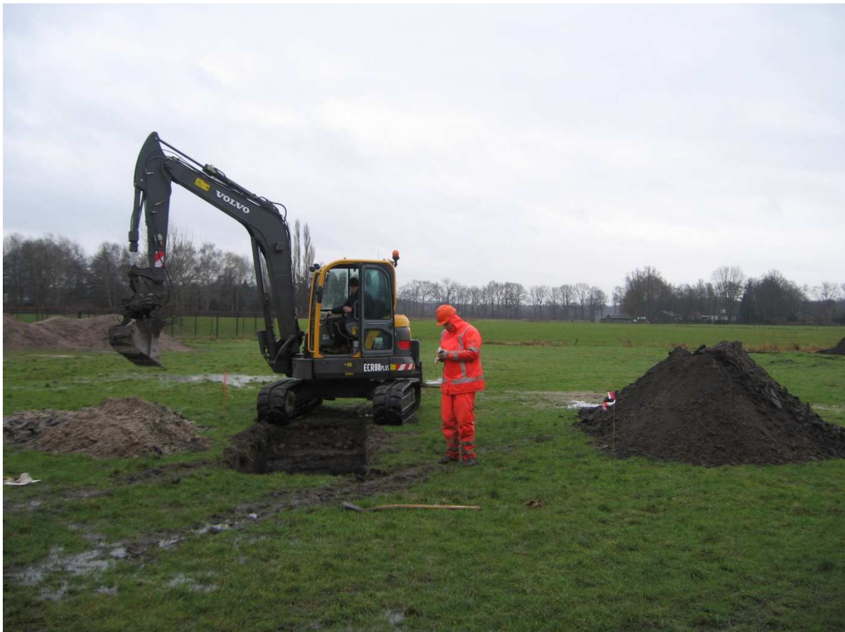
Figuur 2: aanleg van het kijkgat in proefsleuf 1
