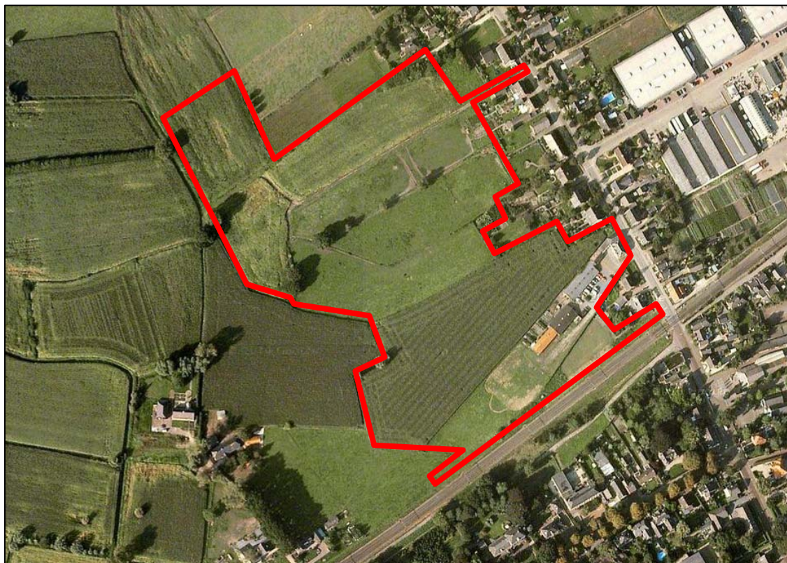
Luchtfoto met weergave ligging van het plangebied ten opzichte van de omgeving
