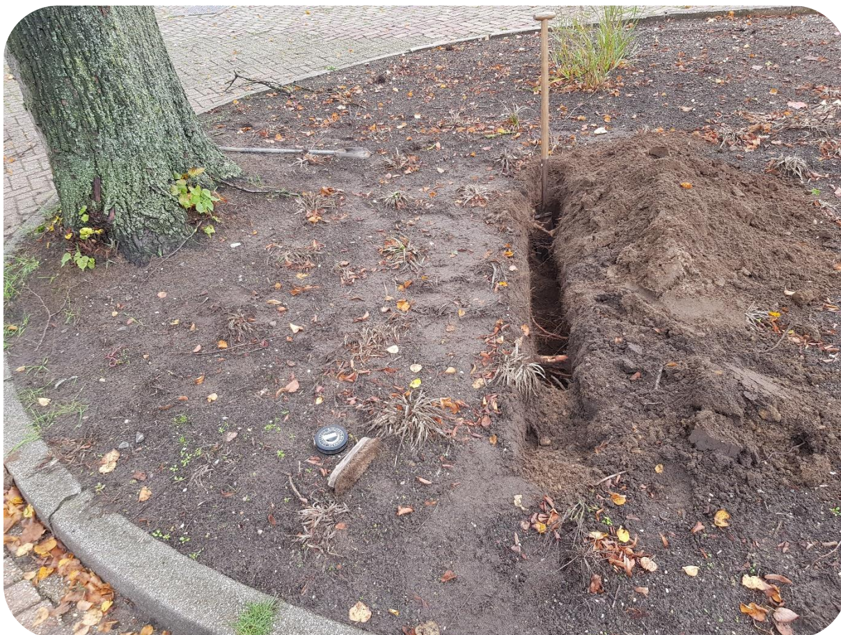
Foto 12: locatie proefsleuf zuidzijde van boom nummer 2
