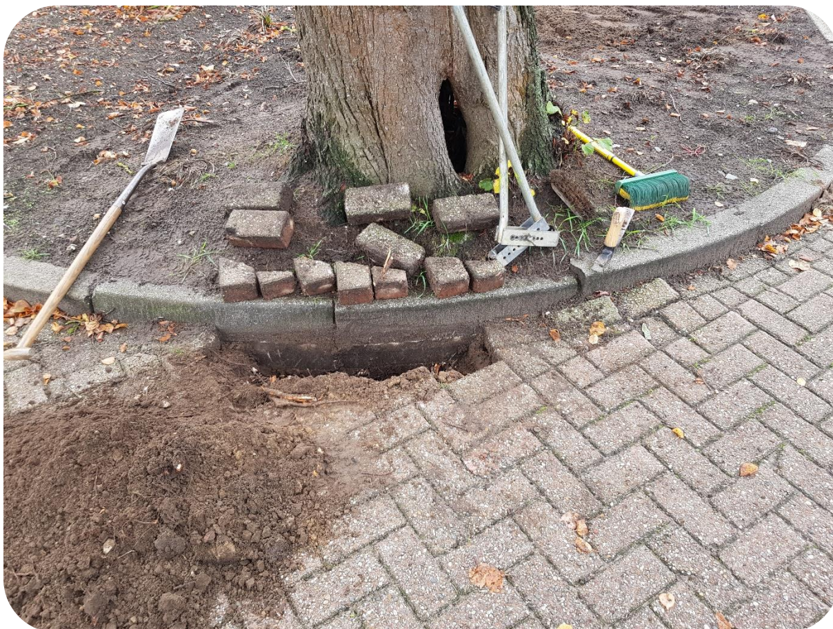
Foto 9: locatie proefsleuf noordzijde van boom nummer 2
