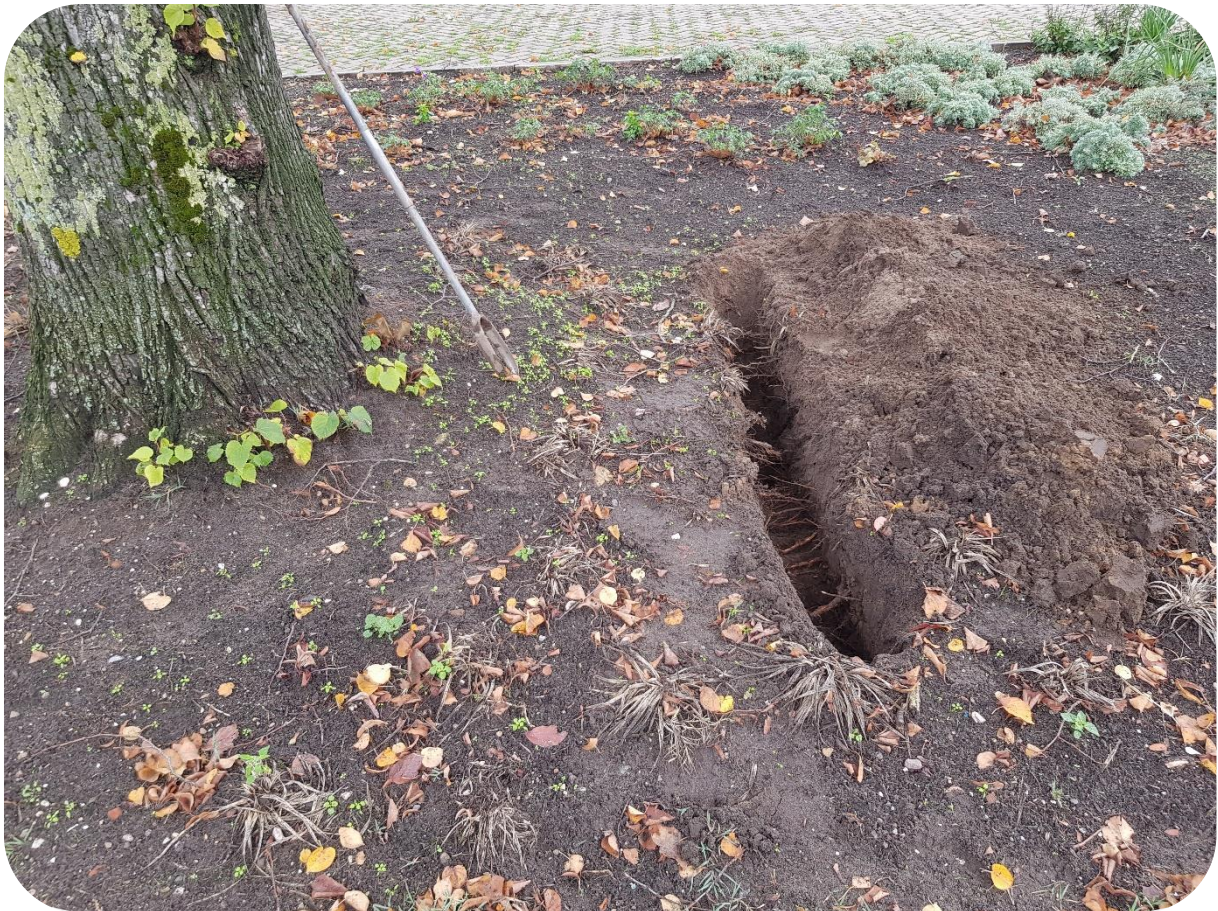
Foto 18: locatie proefsleuf zuidzijde van boom nummer 3
