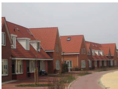
Eenduidige bebouwingswand met accenten op de kappen
