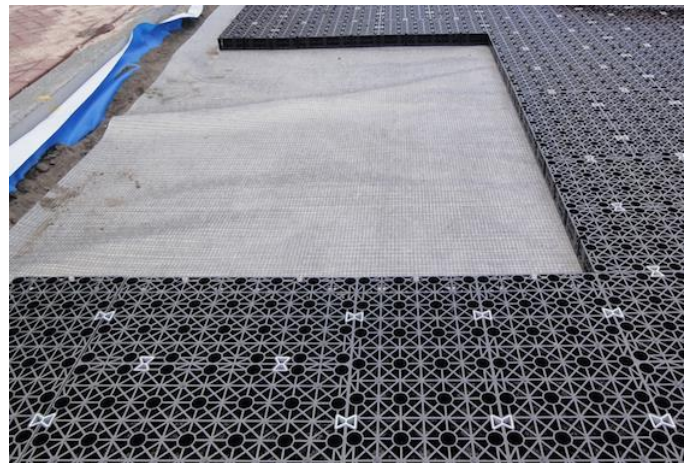
Foto 5: Permavoid sandwichconstructie 85mm (bron: tgs.nl)
