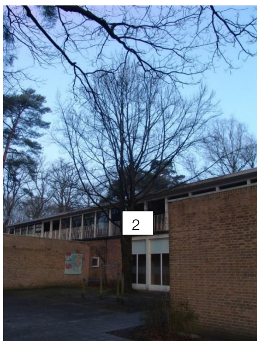
Foto 3: Boom nr. 2 staat dicht bij de gevel
