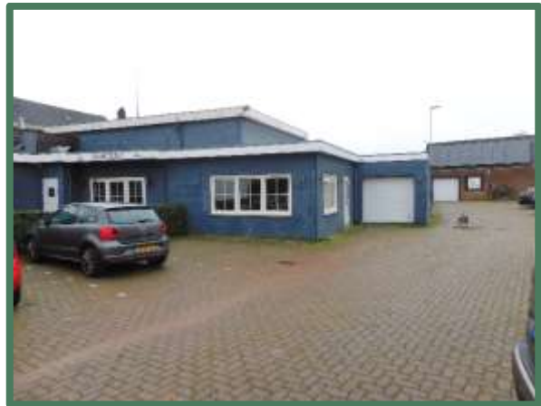
Achterzijde plangebied met rechts parkeerplaats
