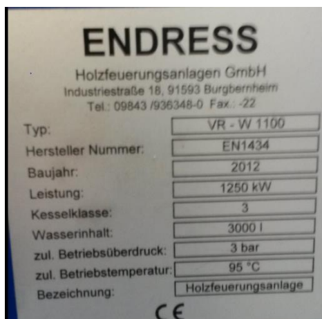
Figuur 2.3 Typeplaatje van de biomassacentrale
