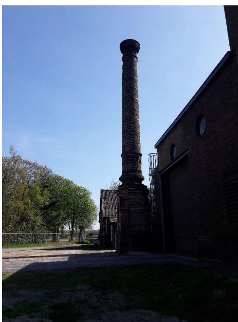
Afbeelding 4. Noordoostkant van de fabriek, gezien richting het zuidwesten (foto: Antea Group).
