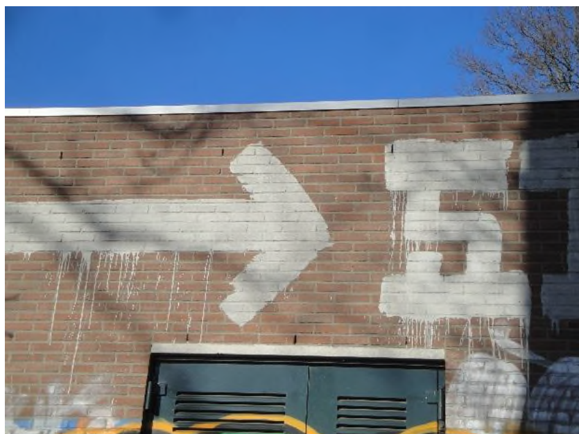
Figuur 8: Foto detail gevelaanzicht huidige situatie
