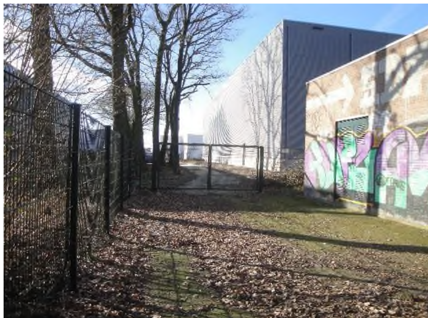
Figuur 5: Foto uiterlijke verschijningsvorm huidige onderstation
