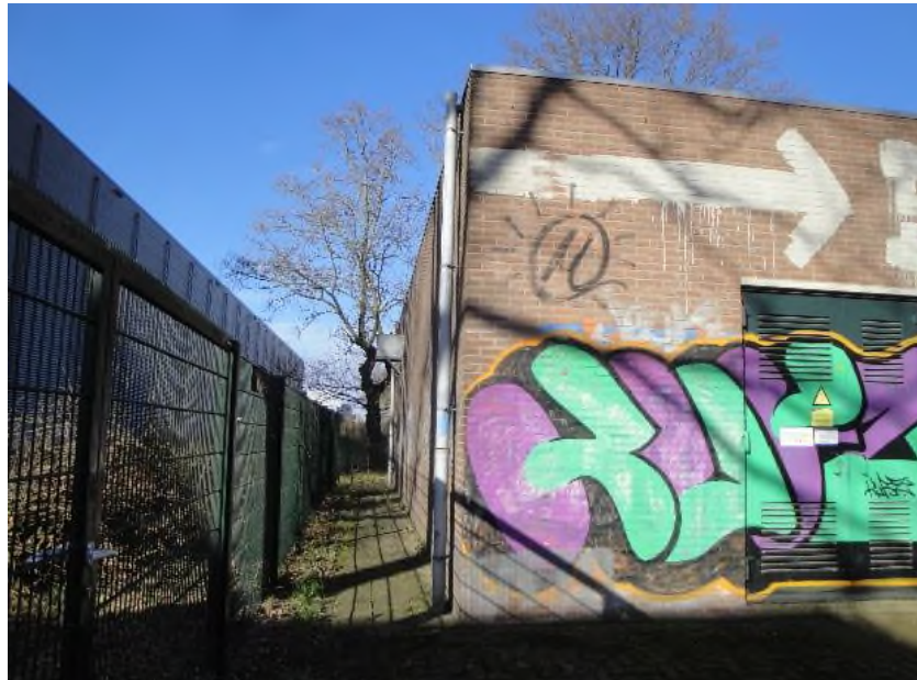
Figuur 7: Foto detail gevelaanzicht huidige situatie
