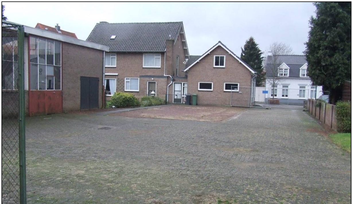
Figuur 18: Plangebied nabij de boringen 2 en 4, gezien in westelijke richting met links het gebouw met de voormalige landbouwsmederij.
