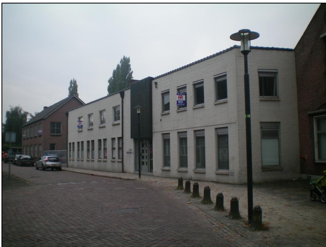
Afbeelding 2.3 Huidige bebouwing langs de Alpheneweg
