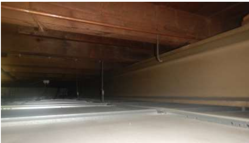
Overzicht vloeropbouw boven systeemplafond
