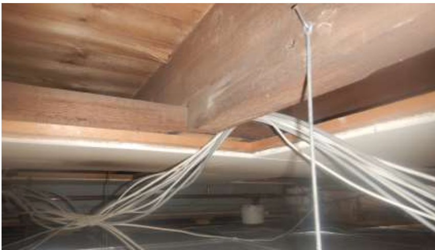
Overzicht vloeropbouw boven systeemplafond
