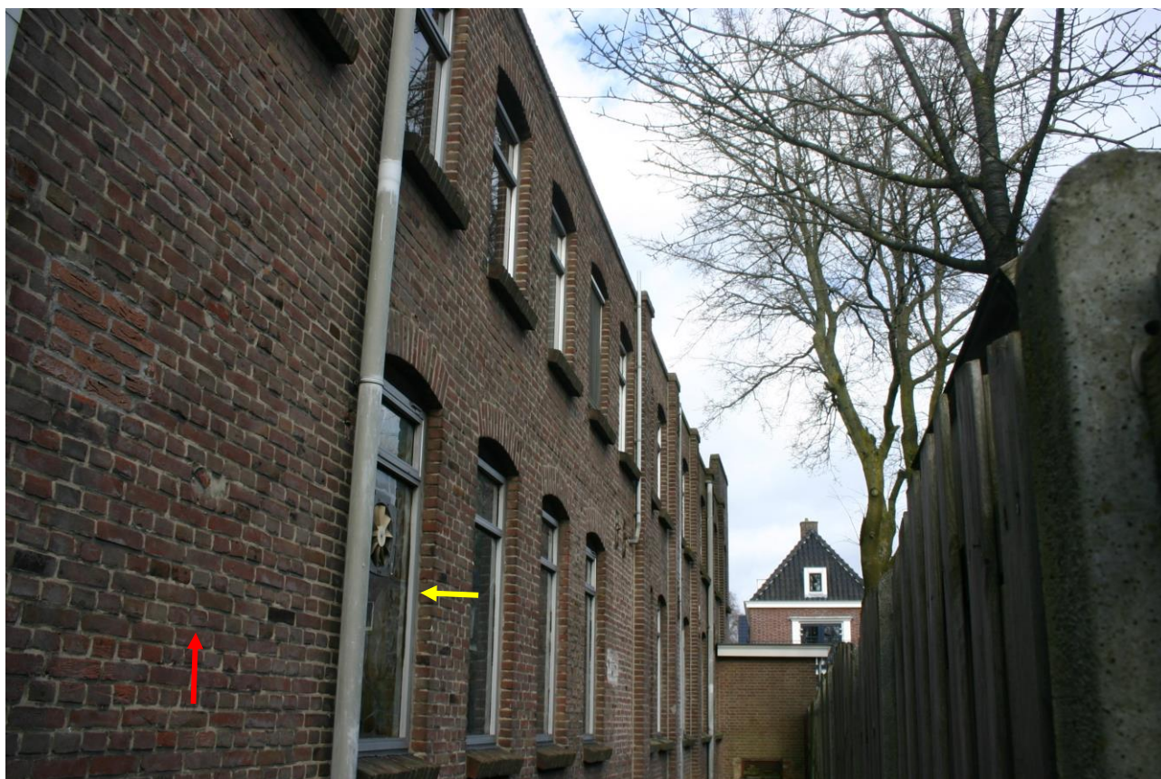
Figuur 4.4.1. Oostgevel. Er zijn geen openingen in het stenen gebouw aanwezig waardoor vleermuizen naar binnen kunnen. Een spouw was origineel afwezig; er zijn daarom geen open stootvoegen (of andere ventilatieopeningen) in het buitenblad aanwezig (zie rode pijl). Ook is er nergens ruimte tussen de kozijnen en de buitengevel (goed te zien bij de gele pijl).
