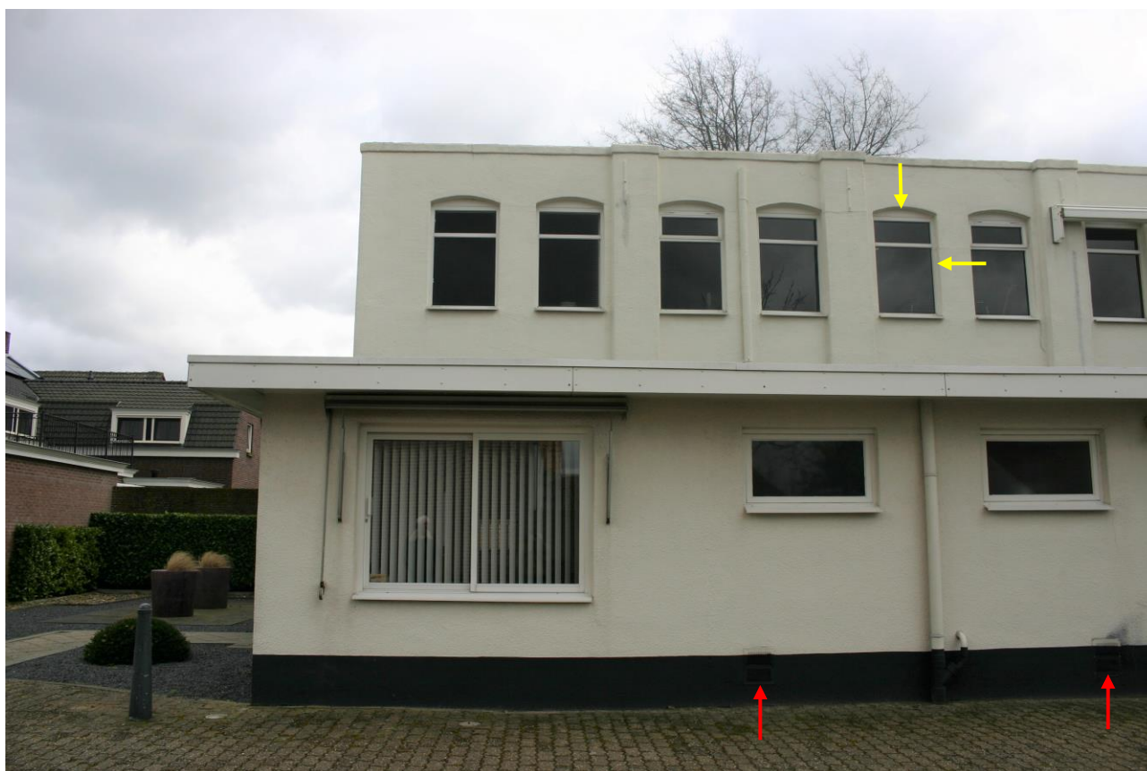
Figuur 4.4.2. Westgevel. Ook hier zijn openingen in de gevel afwezig, op enkele roosters op enkelhoogte na (rode pijlen). De kozijnen sluiten rondom nauw op de gevel aan (gele pijlen). Ook de vensterbanken kieren niet met de kozijnen of gevels.
