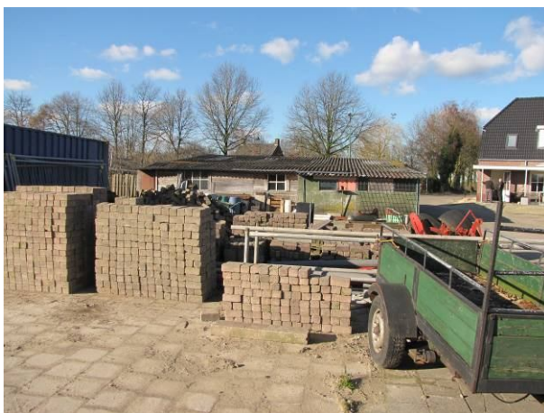
Agrarisch erf met te slopen bedrijfsgebouw
