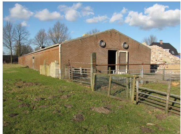
Te slopen varkensstallen gezien vanaf de achterzijde
