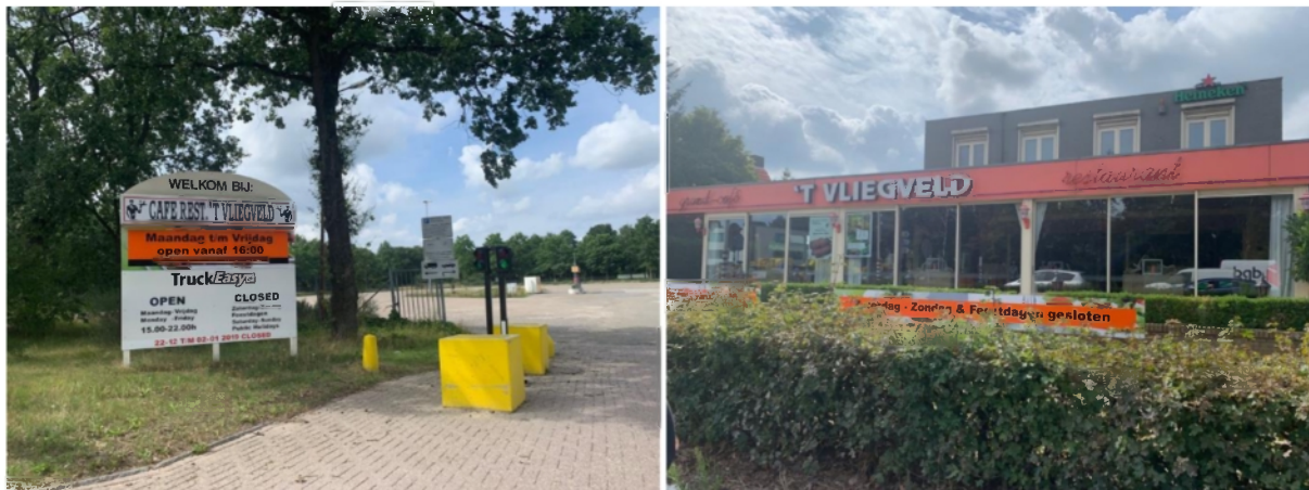
FIGUUR 6 HUIDIGE PAND EN ACHTERGELEGEN PARKEERPLAATS VAN DE RIJKSWEG 25
