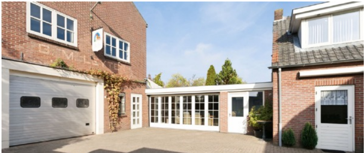
Aanzicht bedrijfsgebouw (hoofdgebouw), veranda (midden) en bedrijfswoning (rechts)
