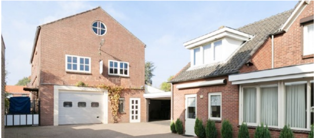
Aanzicht bedrijfsgebouw (het hoofdgebouw, links) en de bedrijfswoning (rechts) vanaf Laagstraat gezien
