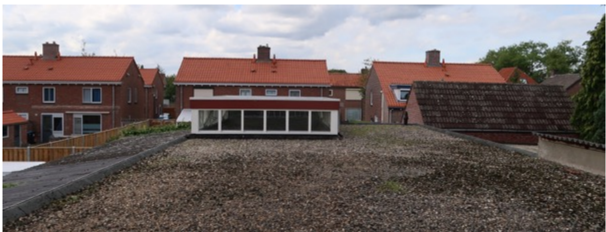
Aanzicht achterliggende gedeelte van voormalige leerfabriek met zicht op te behouden lichtstraat (vanaf 1 ste verdieping hoofdgebouw gezien)
