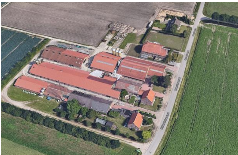
Fig.2. (Luchtfoto Google Earth)
