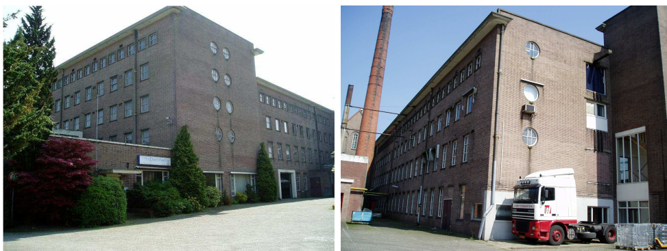
Foto's bestaande situatie fabriek
