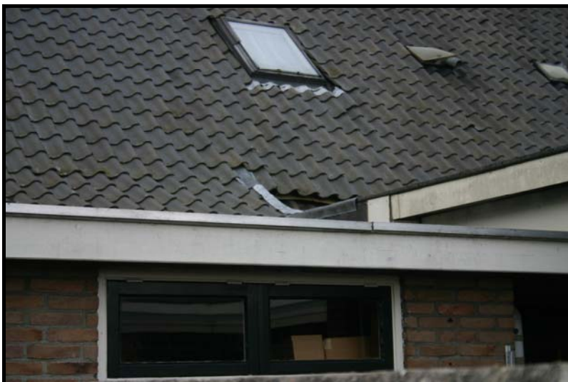
Figuur 2: Deel van het dak op Heuvel nrs. 2 en 3.
