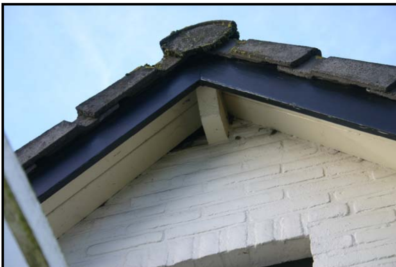
Figuur 4: Opening aan de achterzijde van Heuvel 1.
