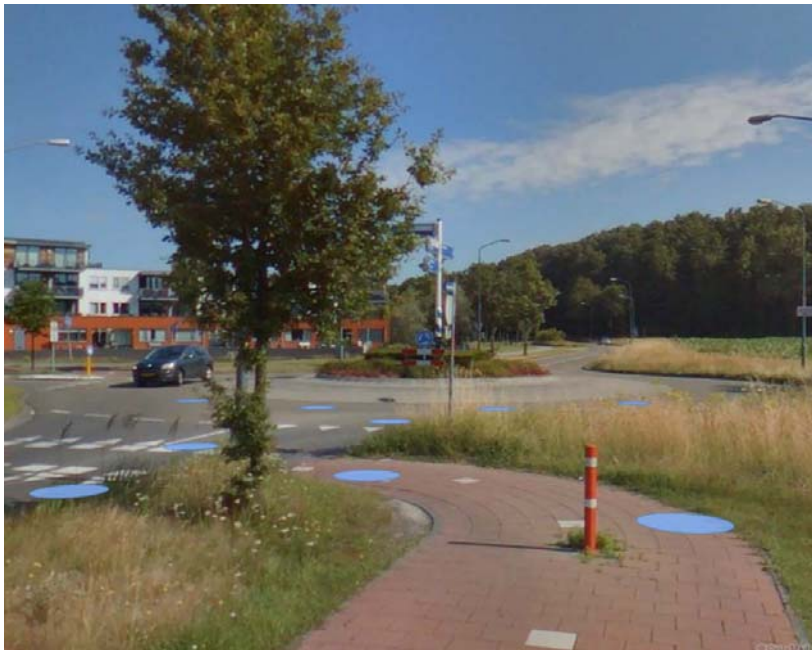
figuur 5.1: Europalaan-rotonde met fietspad en calamiteitenpaaltje (bron:cyclomedia)
