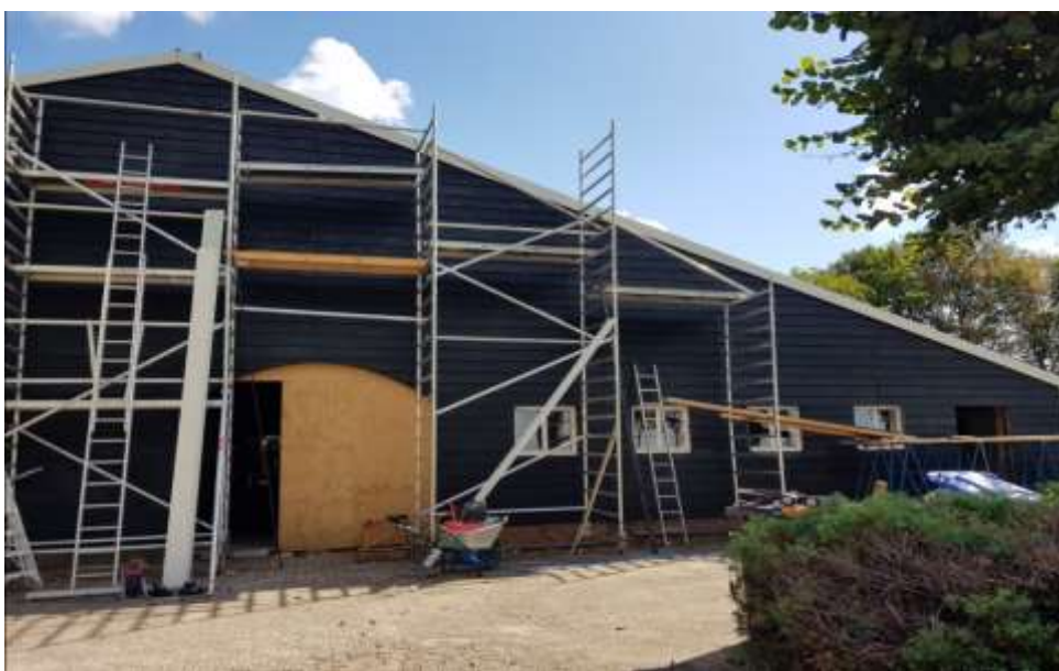
Figuur 2.1: Weergave huidige situatie van het plangebied. De voormalige agrarische bebouwing is in transitie.
