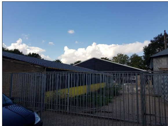
Figuur 6. Oostelijke deel gerenoveerde stal
