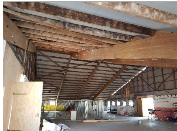
Figuur 4. Binnenzijde gerenoveerde stal
