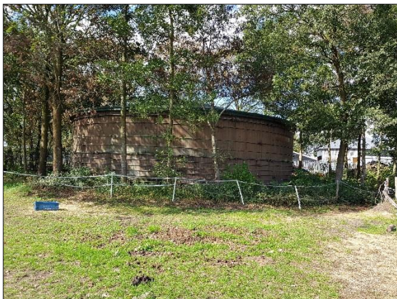
Figuur 7. Te slopen mestopslag
