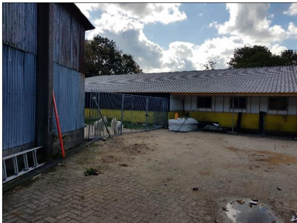
Figuur 5. Oostelijke deel gerenoveerde stal
