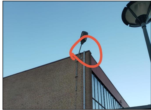
Figuur 6. Invlieglocatie gierzwaluw achter regenpijp aan noordwestelijk georiënteerde gevel van pand (rechterhoek).
