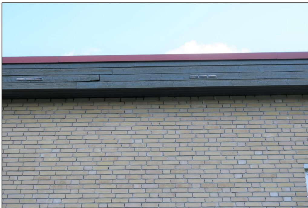
Figuur 2 De bebouwing heeft een plat bitumen dak met een metalen daklijst en houten panelen.
