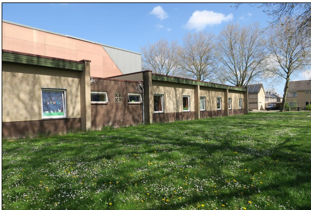
Figuur 1 De planlocatie betreft bebouwing opgetrokken uit stenen muren met spouw en damwandplaten.
