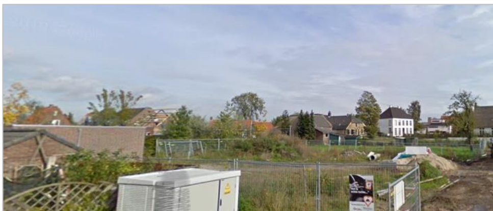
Foto 1: Planlocatie Burgemeester Moonshof ten tijde van nieuwbouw ten zuiden plangebied.
