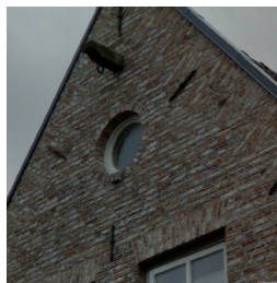
karakteristiek metselverband als overgang naar dakconstructie
