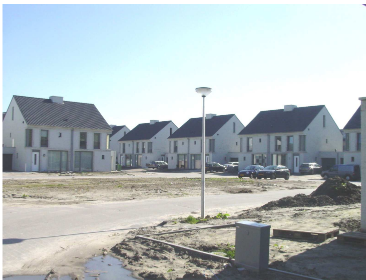
woningen in aanbouw in Schoenmakershoek
