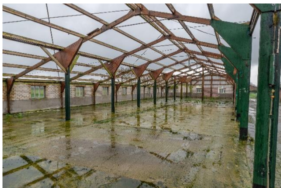
Zuidelijke loods zonder dak
