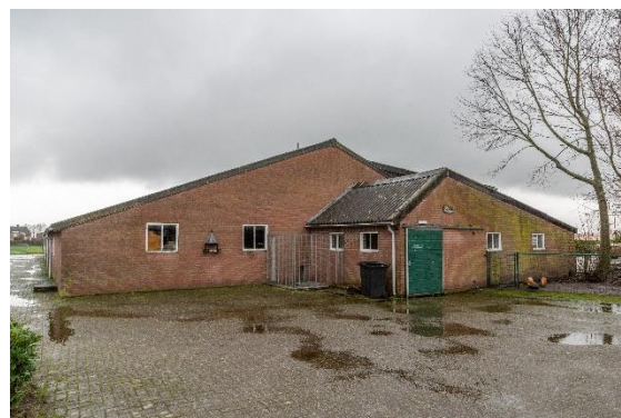
Noordelijke loods zonder gevelbetimmering
