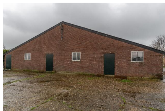
Noordelijke loods zonder gevelbetimmering
