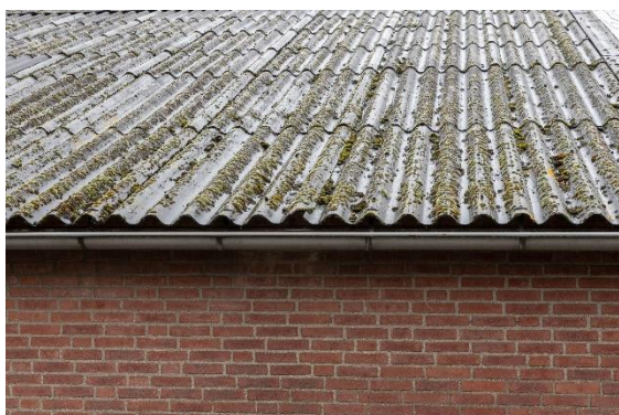
Dichte aansluiting van de golfplaten op de gevel.
