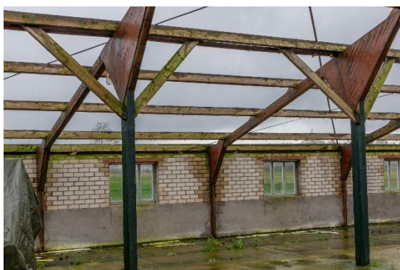
Zuidelijke loods zonder dak
