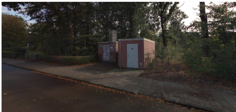
Figuur 4.3: Bomen en Trafohuisjes Tamboerijn (bron: Cyclomedia).
