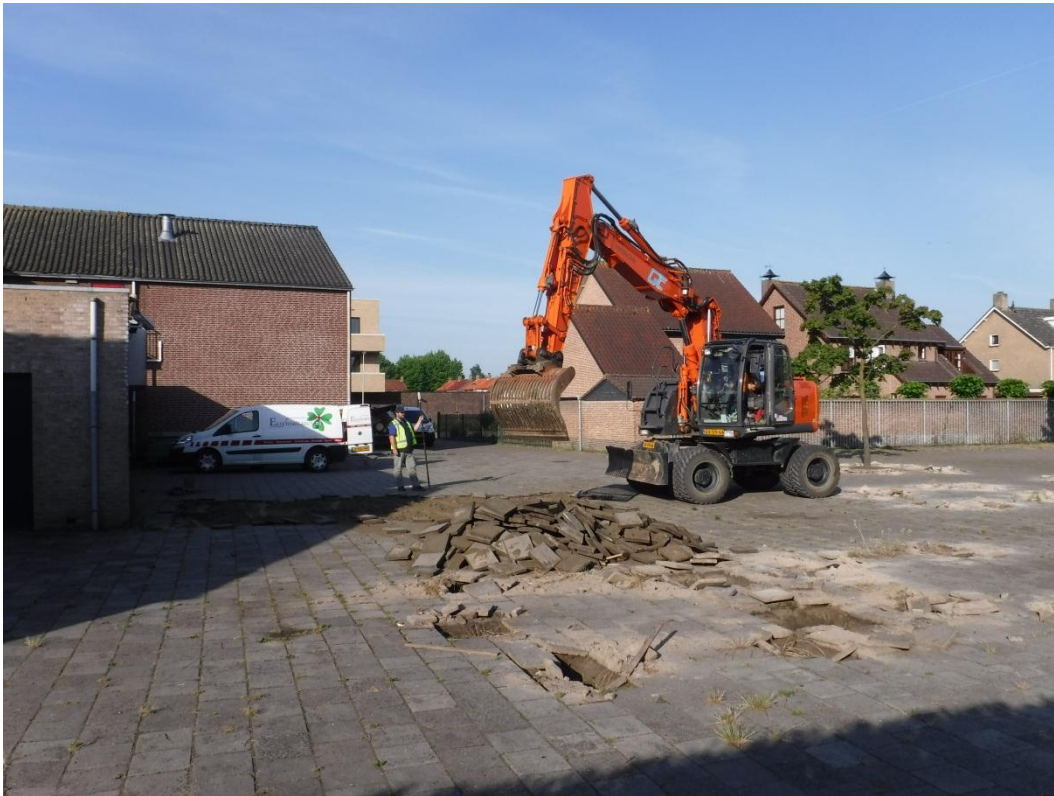
Figuur 1. Overzichtsfoto van de werkzaamheden binnen het plangebied.
