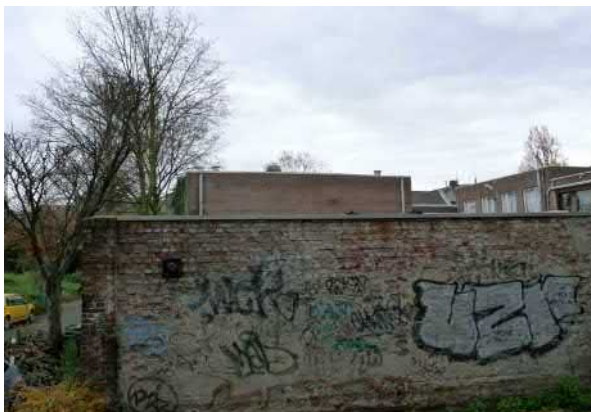
Figuur 3: Zijaanzicht bebouwing (garage) direct naast het plangebied. Deze garage is tegen de te slopen garage aangebouwd.
