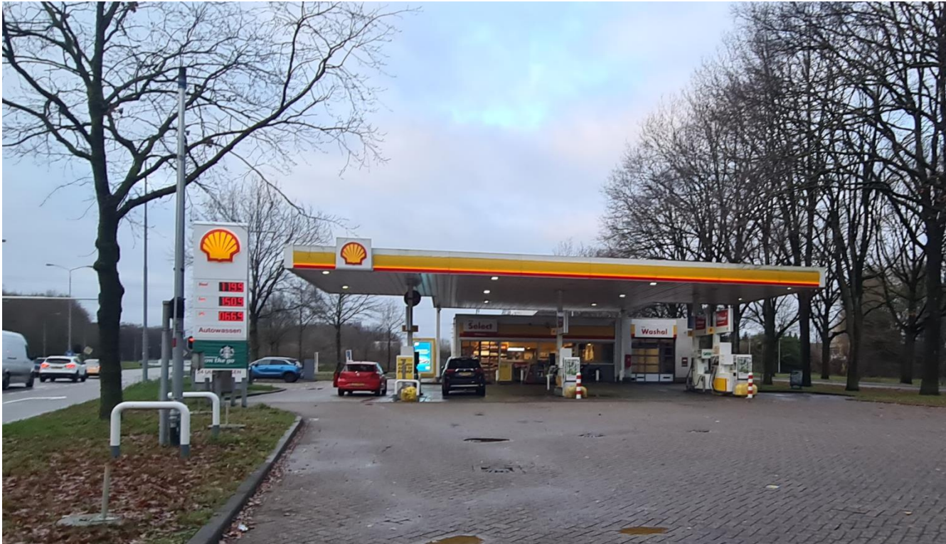
Figuur 4: Huidig tankstation aan de Cor Gehrelsloaan, gezien vanuit het oosten
