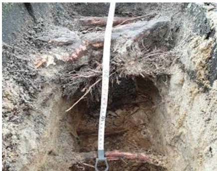
Afbeelding 17: intensieve beworteling onder de verharding
