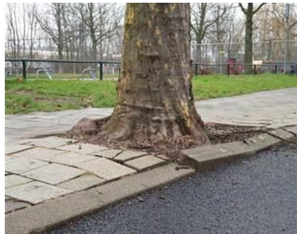
Afbeelding 7: bij veel bomen is sprake van wortelopdruk in de verharding
