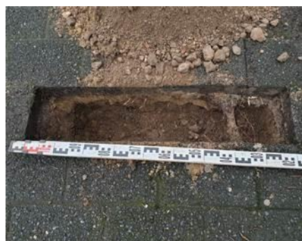
Afbeelding 32: puin in het profiel maakt verder bodemonderzoek niet mogelijk
