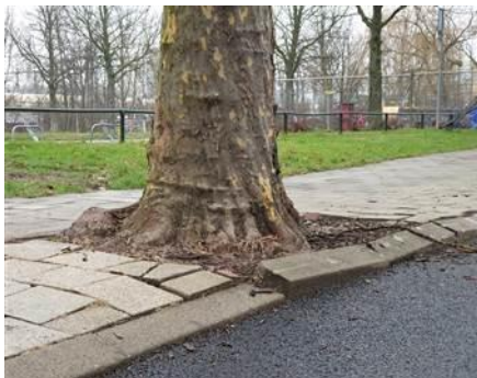
Afbeelding 13: veel bomen staan in kleine boomspiegels in de verharding en veroorzaken opdruk
