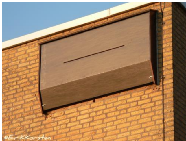
Figuur 4.2. De Korstenkast. Foto door Erik Korsten.
