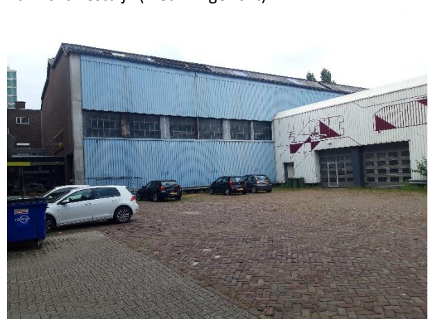
Fotonummer: 28 Binnenterrein Vestdijk 27 (beklinkerd)
