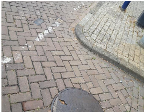
Fotonummer: 20 Peilbuizen en put bij Parkeerautomaat
