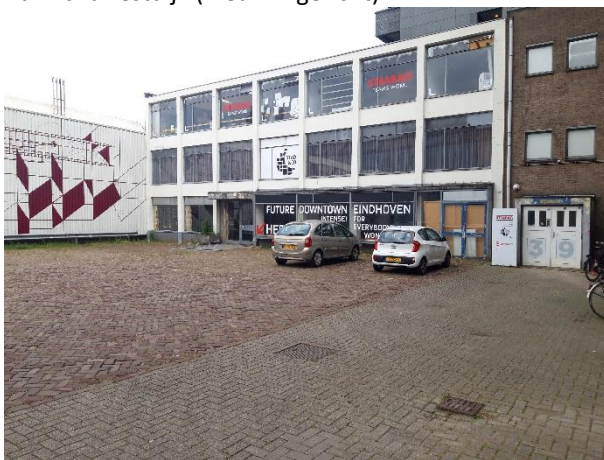
Fotonummer: 27 Binnenterrein Vestdijk 27 (beklinkerd)
