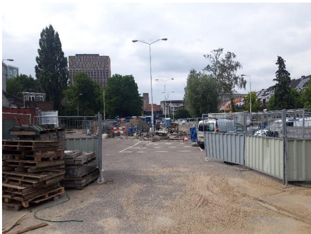
Fotonummer: 13 Parkeerterrein achterzijde richting Pullman
