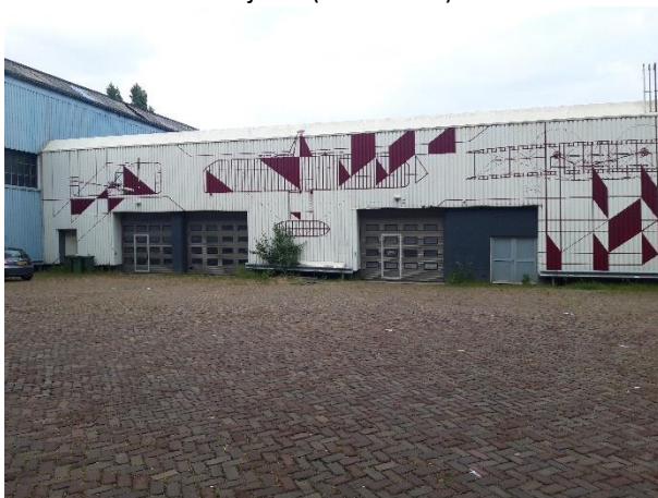
Fotonummer: 29 Binnenterrein Vestdijk 27 (beklinkerd)
