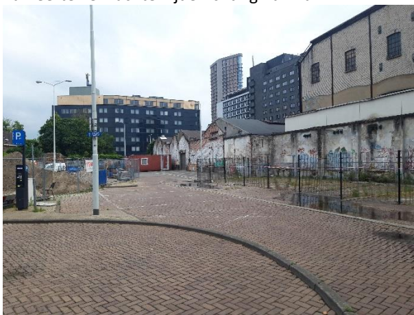
Fotonummer: 9 Parkeerterrein achterzijde richting Pullman
