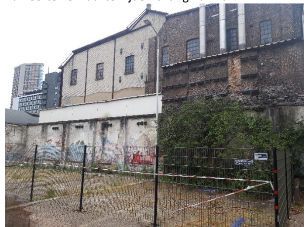
Fotonummer: 10 Parkeerterrein achterzijde Vestdijk 27
