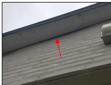
Figuur 11. Spleten langs de boeidelen
