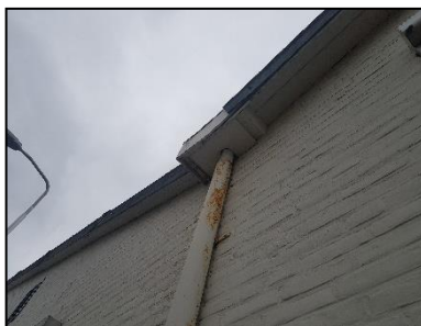
Figuur 7. Ruimte tussen regenpijp en houten ombouw dakgoot
