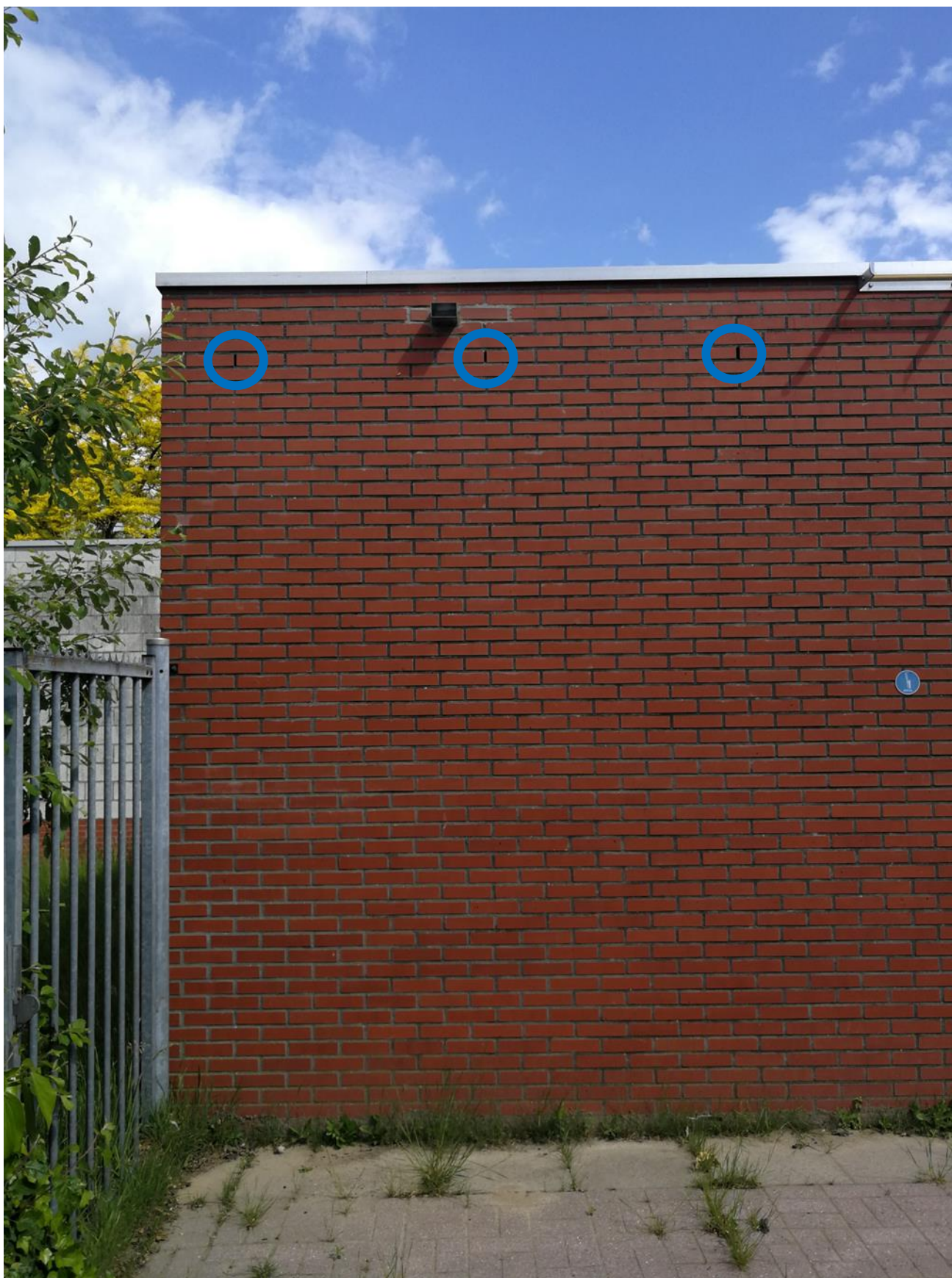
Figuur 6 Voorbeeld van stootvoegen die rondom aanwezig zijn in het pand
